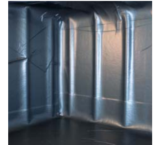
3. fenosafe®-Innenhülle eingebaut
