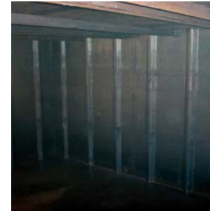
1. Gereinigter Tank von innen
